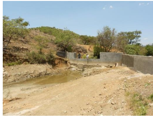
Figura 6. Muro terminado de la represa, extremo lateral ya delimitado conservando el nivel del vertedor de demasías y dragado del vaso de almacenamiento.
