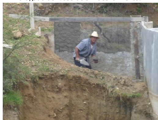
Figura 6. Muro terminado de la represa, extremo lateral ya delimitado conservando el nivel del vertedor de demasías y dragado del vaso de almacenamiento.
