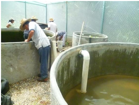
Figura 13. Sistema tipo para el llenado y descarga de cada tanque.
