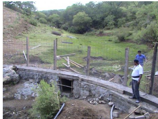
Figura 4. Mampostería concluida y malla anclada en la losa para formar el muro de ferrocemento.
