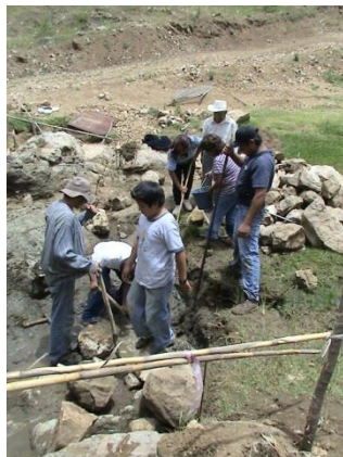
Figura 3. Retiro de lodos y lavado antes de iniciar con la cimentación.
