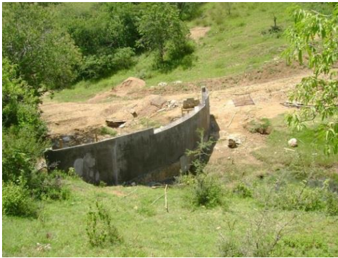
Figura 5. Muro concluido antes de delimitar la parte lateral.
