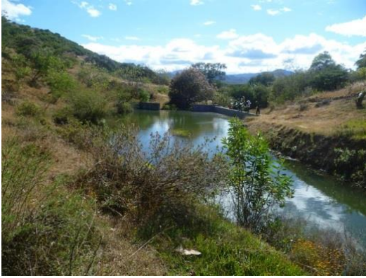
Figura 9. Aspecto de la obra en funcionamiento.
