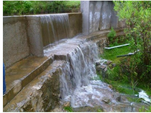
Figura 10. Vertedor de demasías de la represa de almacenamiento operando.
